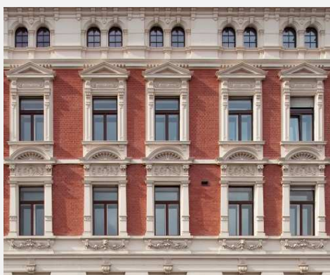
Sanierung Denkmalobjekt Paderborn, Fürstenweg
