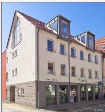
Neubau Wohn- / Geschäftshaus Soest, Grandweg 4
