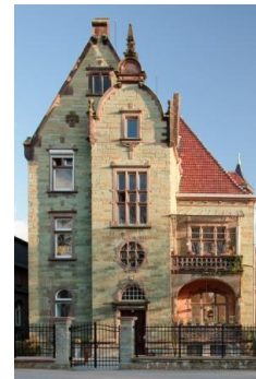
Sanierung Gründerzeitvilla Soest, Westenhellweg 11
